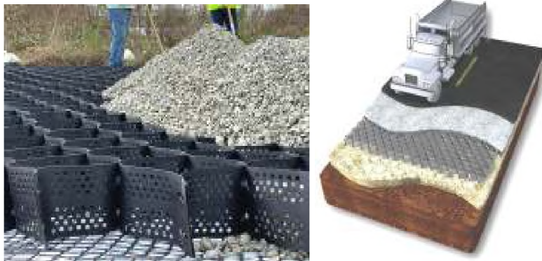
Hình 3: Gia cố nền đất yếu bằng lưới địa kỹ thuật dạng khối
