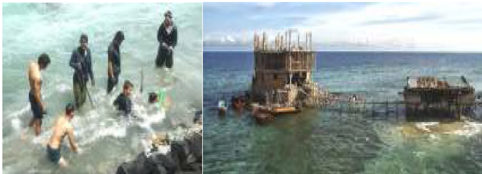
Hình 5: Đào móng và xây dựng các tầng
