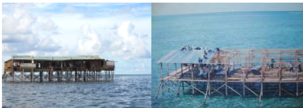
Hình 4: Xây dựng nhà tạm
