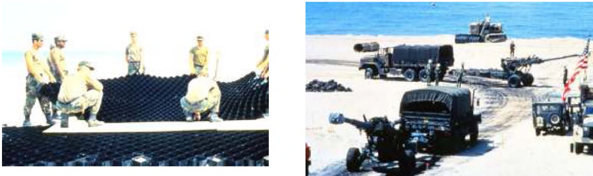
Hình 7: Sử dụng lưới địa kỹ thuật dạng khối tại cuộc tập trận quân sự JLOTS II năm 1983
