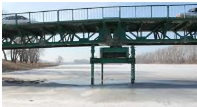
Hình 6: Cầu thép lắp ghép SARM
