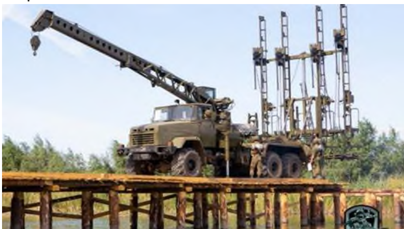
Hình 7: Sử dụng tổ hợp UCM-3 Bắc cầu gỗ
