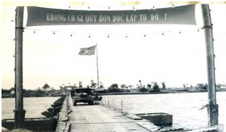
Hình 2. Cầu phao qua sông Bến Hải do Trung đoàn công binh 249 bắc, năm 1972
